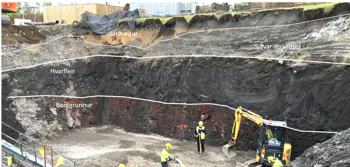
Mynd 4 Jarðlög og berggrunnur við dælustöð við Krókalón, norðvestan við Vesturgötu 69.
