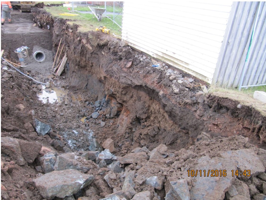
Mynd 18 Frá jarðvinnu við lögn aftan við Vesturgötu 83, klöpp neðst í skurði, áætlað 1-1,5 m á klöpp frá yfirborði.
