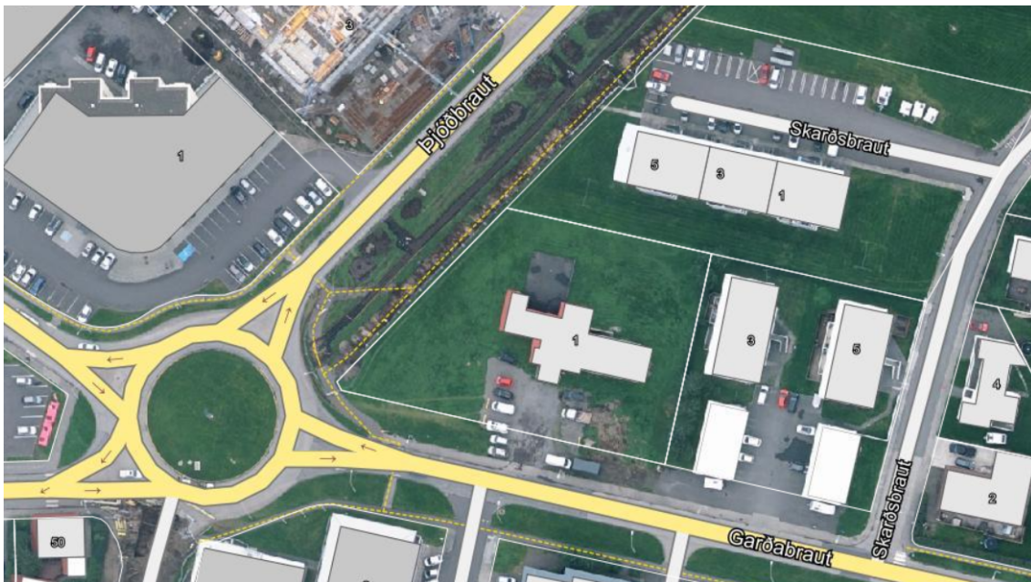
Loftmynd af Garðabraut 1, Akranesi
