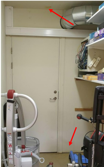
Sýni B10, B11, B12: Samkvæmt upplýsingum þá flæddi í loftræsikerfi skólans á þessum stað og það þurfa að fara fram meiri úrbætur á byggingarefnum sbr. Niðurstöður og myndir.
